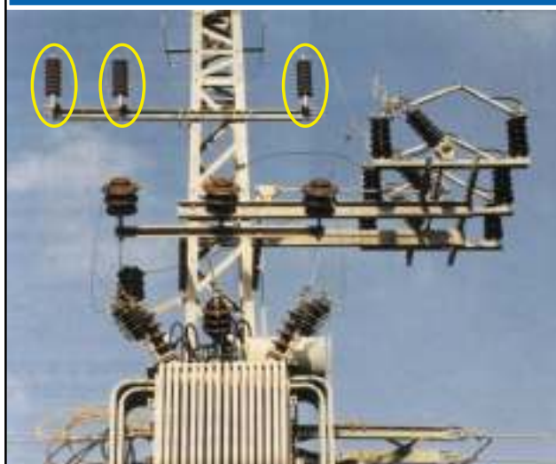
איור 1: מגיני ברק המותקנים על עמודי מתח גבוה לשם החלשת "מתחי יתר חולפים"
