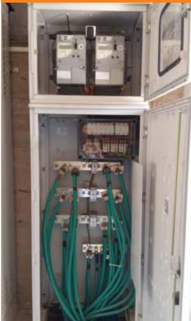
איור 3: התקנת מונה ייצור של מתקן פוטו-וולטאי בתא מנייה דו-קומתי
